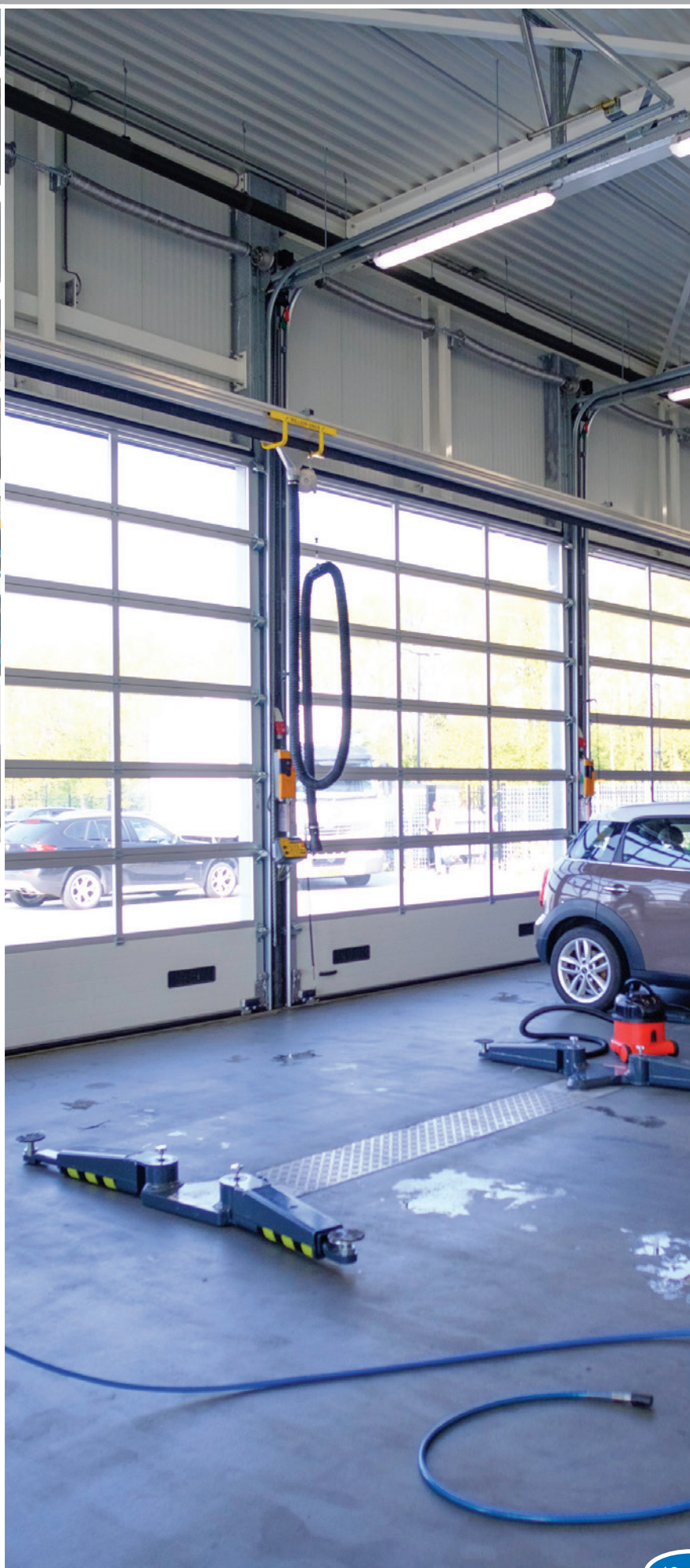
U-стойност на секционна врата NovoLux 40 мм: 5000 x 5000 мм: 3,87 W/m 2 K
